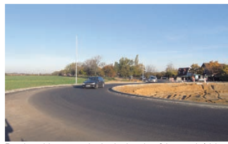
Rondo turbinowe na drodze krajowej nr 94 przy wjeździe do miasta od strony Wrocławia
