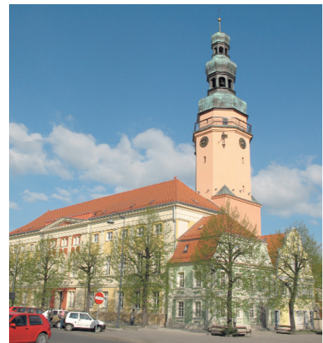
Budynek przebudowywanego wnętrza Ratusza
